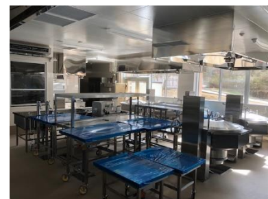
【1階 給食棟の内部】
