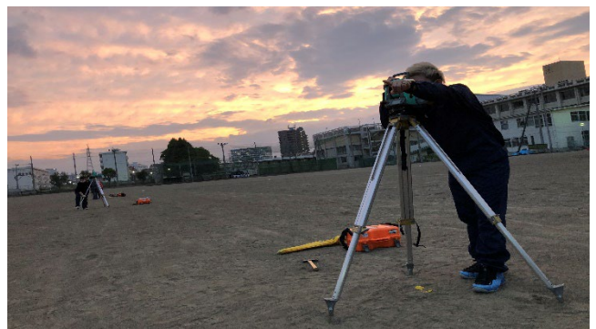
建築土木科 校庭での測量据付実習
