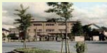
旧校舎 (昭和30年代) 北側より
