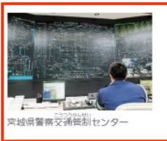
そこで宮城県警察交通管制センターを見学し、車がじゅうたいしないように信号の時間を変えることも、事故を防ぐ取組なのだを教えてもらいました。下の図は交通事故が起きた時の連絡の仕組みです。写真「宮城県交通管制センター」宮城県警察本部内にあり、仙台市内及び周辺の信号機を制御している。車両感知器やテレビカメラを通して道路の渋滞状況が分かるようになっている。110番を取り扱う通信司令室に併設しており、併せて見学が出来るようになっている。
