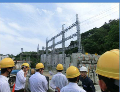
電気設備見学
