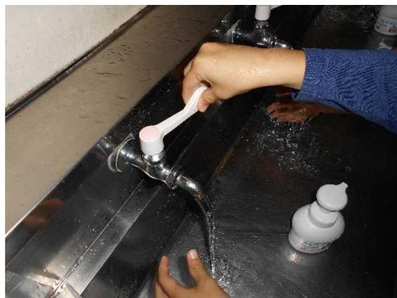
手洗い場の一部の水栓をレバー式に替えました。力を入れず、レバーを左右に動かすだけで水が出るので、低学年でも使いやすくなりました。手を蛇口に触れる時間も短くなり感染予防にもなります。
