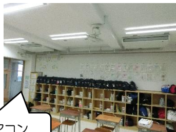
天井にエアコン
