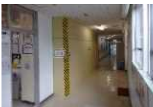
1階3の1横(階段工事)
