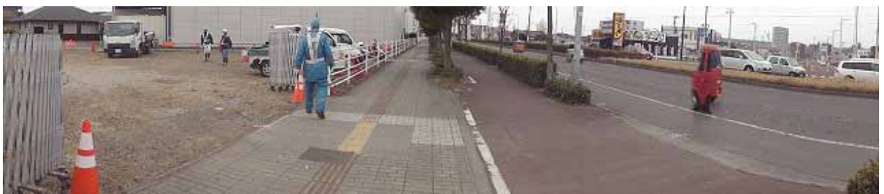
写真 9・10 工事中の郡山折立線（平成 29 年 2 月） ※カメラのパノラマ機能を利用して撮影
