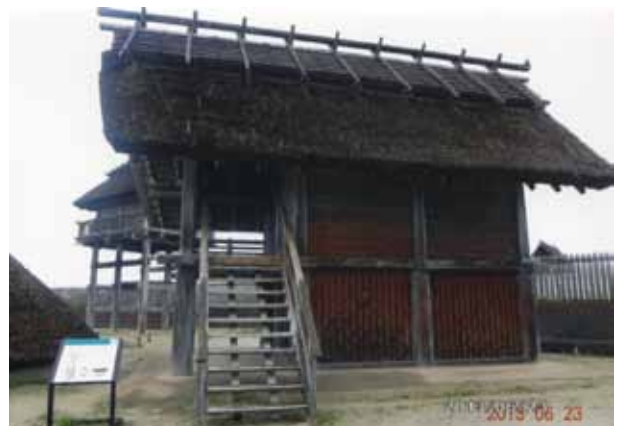
写真 1 2 北内郭 掘立柱式の高床建物
