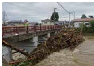
仙台市泉区根白石の 被害の様子
