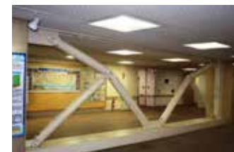
建物内部の制震装置
