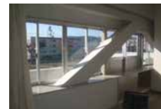
耐震補強された教室
