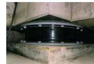
ビルの基礎の免震装置
