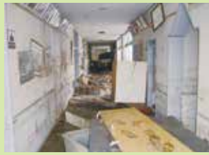
被害を受けた東六郷小の校舎内
