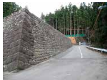
復旧工事終了後 (平成27年2月)
