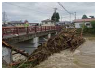
仙台市泉区根白石の 被害の様子
