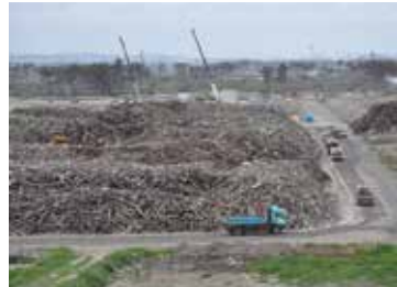
沿岸部の震災がれき置き場
