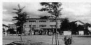
旧校舎 (昭和30年代) 北側より
